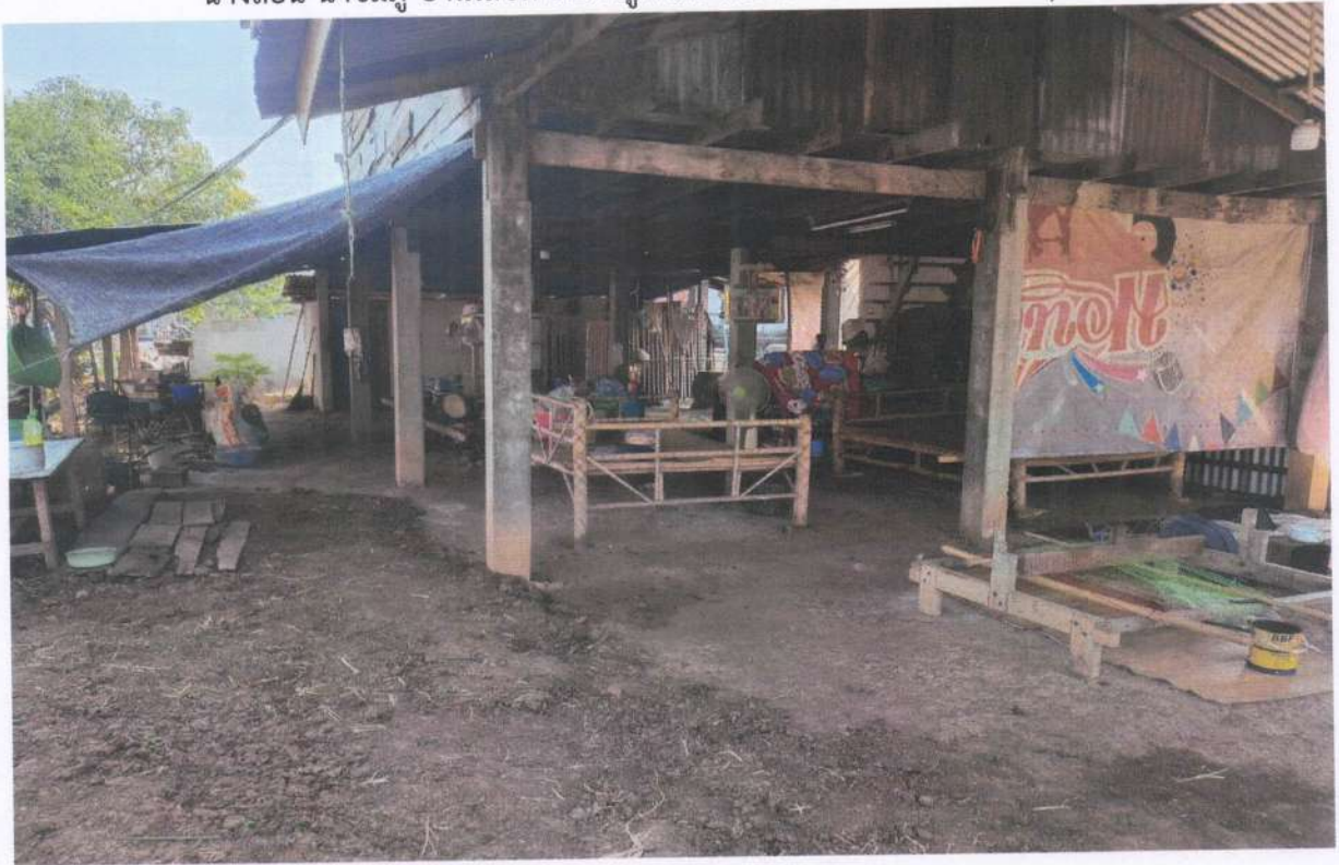
ภาพประกอบบ้านผู้สูงอายุที่ต้องการปรับปรุง/ซ่อมแซมที่อยู่อาศัย โครงการการปรับสภาพแวดล้อมและสิ่งอำนวยความสะดวกของผู้สูงอายุให้เหมาะสมและปลอดภัย ประจำปีงบประมาณ พ.ศ. ๒๕๖๙ นางสอน นามงู บ้านเลขที่ ๒๒ หมู่ที่ ๑๘ ต.ห้วยหิน อ.หนองหงส์ จ.บุรีรัมย์
